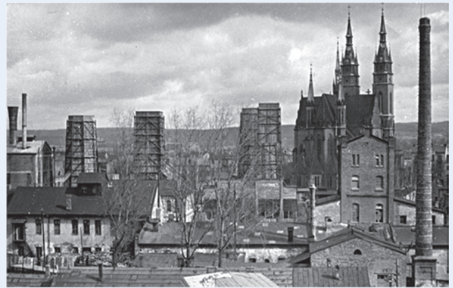
Chłodnie i część budynku głównego Elektrowni Kielce na zapleczu Kościoła Św. Krzyża w Kielcach, lata 20. XX w. (źródło: Muzeum Historii Kielc)
