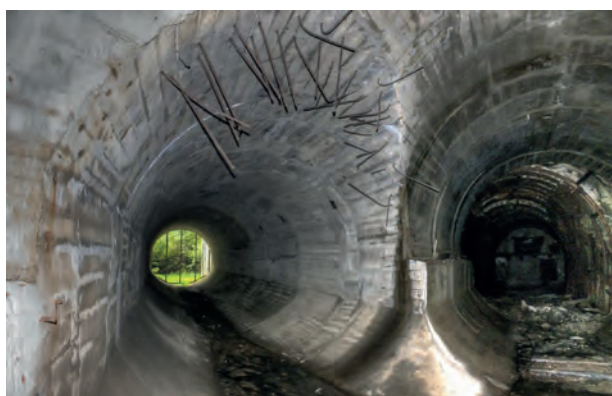
Rys. 4. ESP Młoty – rozgałęzienie sztolni w obudowie żelbetowej Źródło: opuszczone.net
