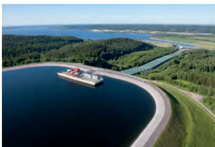
Rys. 5. ESP Żarnowiec – widok od strony zbiornika górnego Źródło: pgeeo.pl
