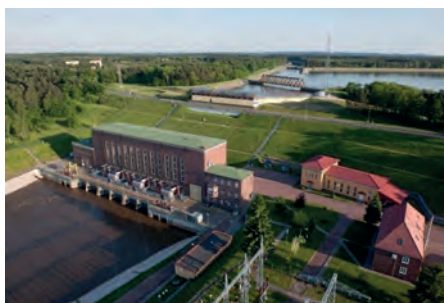
Rys. 6. ESP Dychów – widok od strony wody dolnej Źródło: pgeeo.pl
