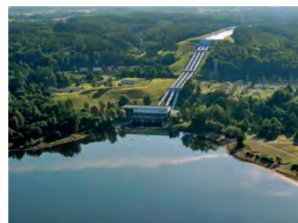
Rys. 10. ESP Żydowo – widok od strony wody dolnej Źródło: energia-wytwarzanie.pl
