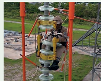
Rys. 25. Wymiana uszkodzonego izolatora [48]
