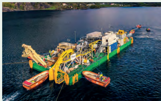
Rys. 7. Stanowisko do układania kabli przez jezioro Suldal oraz tunel serwisowy podczas przeciągania kabla [30]
