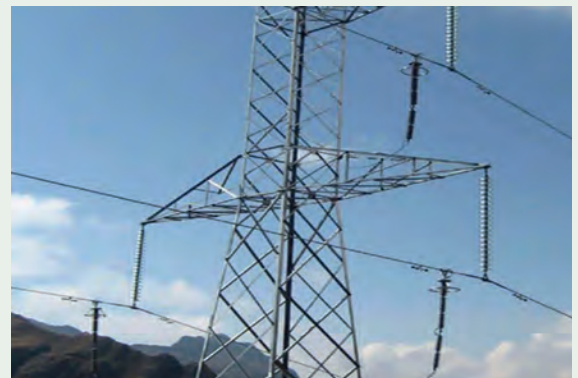
Rys. 26. Linia 132 kV z ogranicznikami przepięć [55]
