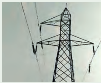
Rys. 26. Linia 132 kV z ogranicznikami przepięć [55]
