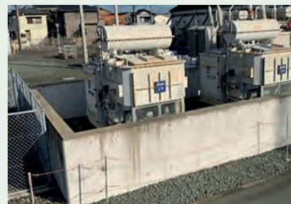
Rys. 13. Ściany przeciwpowodziowe wokół stanowisk transformatorów
