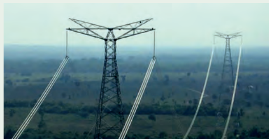
Rys. 24. Linia \pm 800 kV DC (BMTE) [48]
