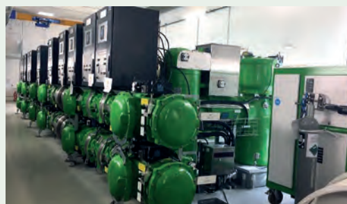
Rys. 4. Rozdzielnica z izolacją gazową wolną od SF 6
