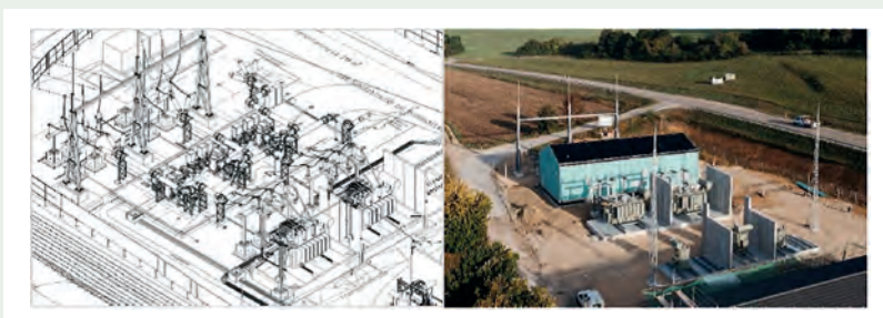
Rys. 23. Cyfrowa i wolna od gazów cieplarnianych stacja 110/20 kV
