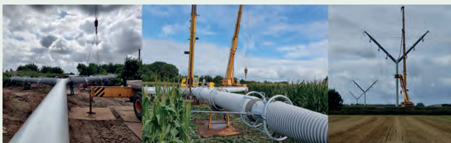
Rys. 31. Zdjęcia z budowy słupa [62]
