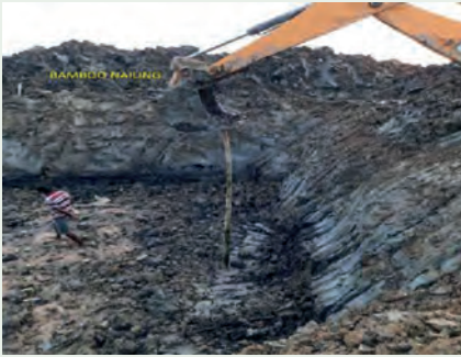
Rys. 5. Pograżanie prętów bambusowych [7]
