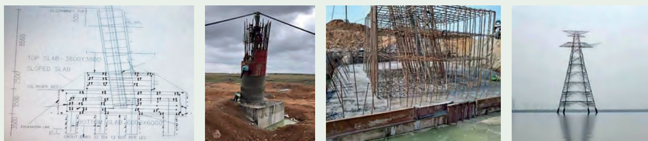
Rys. 1. Rysunek poglądowy oraz zdjęcia fundamentu słupa linii 800 kV DC [8]
