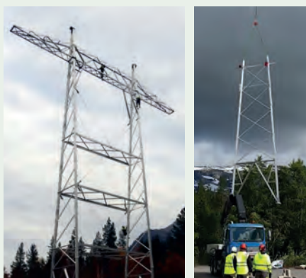
Rys. 7. Projektowany słupek z aluminium (po lewej), transport elementów konstrukcji przy użyciu śmigłowca (po prawej) [20]
