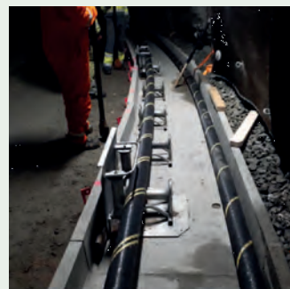
Rys. 7. Stanowisko do układania kabli przez jezioro Suldal oraz tunel serwisowy podczas przeciągania kabla [30]
