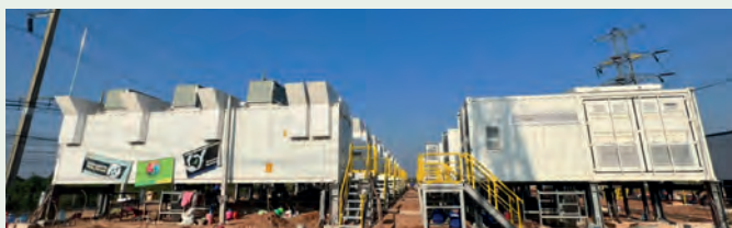
Rys. 7. Wielkoskalowy magazyn baterijny w trakcie budowy
