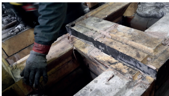
Rys. 9. Widok rozwiązania konstrukcyjnego odbudowywanej głowicy ścian grzewczych remontowanej baterii koksowniczej
