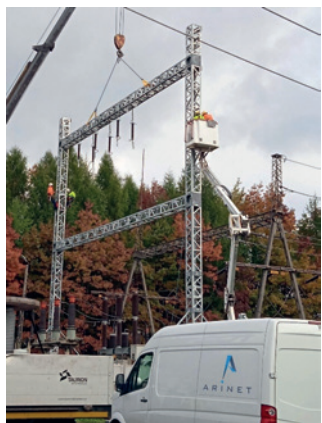
Widok samonośnej tymczasowej liniowej bramki stacyjnej 110 kV w systemie UMKW – GPZ 110/20 kV Lipówka
