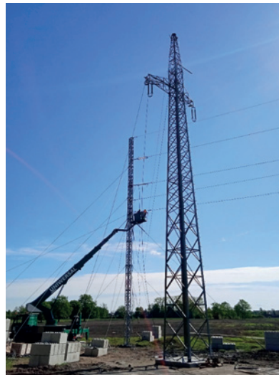
Na pierwszym planie słup serii AWX 131. W tle widoczny słup linii tymczasowej 110kV w technologii UMKW
