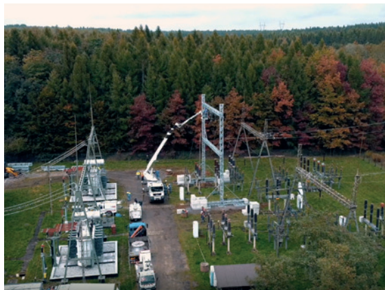
Widok samonośnej tymczasowej liniowej bramki stacyjnej 110 kV w systemie UMKW – GPZ 110/20 kV Lipówka
