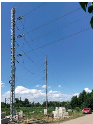
Fragment linii tymczasowej 110 kV relacji Komorowice – Czechowice w technologii UMKW firmy ARINET
