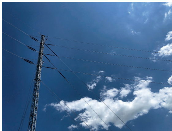
Fragment linii tymczasowej 110 kV relacji Komorowice – Czechowice w technologii UMKW firmy ARINET
